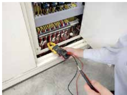
▲ポンプ電圧・電流測定の様子
