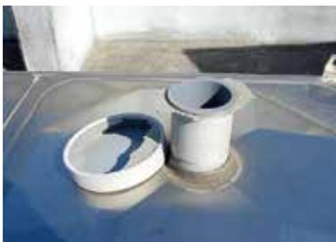
水抜管（排水間隔なし）
